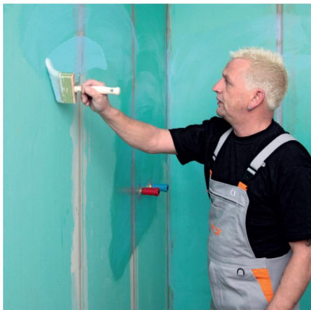
1. Грундиране на минерални или гипсови основи и гипскартон с PCI Gisogrund.
