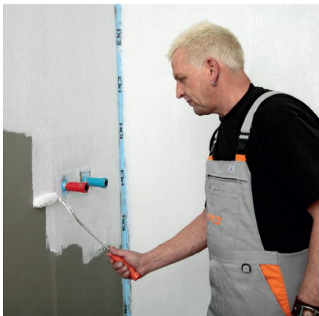
5. Нанасяне на втори слой PCI Lastogum след около 1 час.
