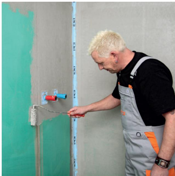
4. Нанасяне на първи слой PCI Lastogum плътно върху основата
